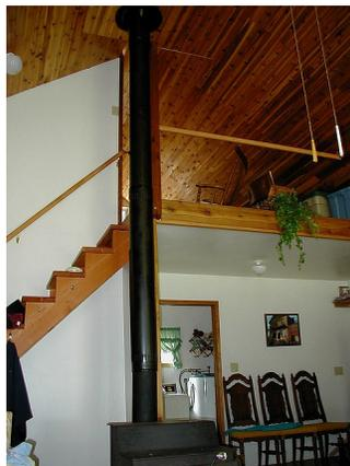
Como se aprecia en la figura, es necesario realizar una perforación en el techo para hacer pasar el tubo que conduce el humo al exterior. Dado que la sección del tubo de la chimenea es circular, habitualmente se procede realizando un corte con esa forma.
