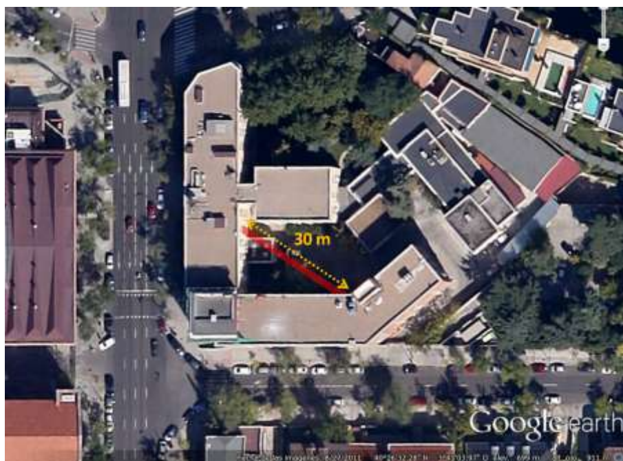
Figura 188. Enlace de 30 metros entre laboratorios del Instituto Leonardo Torres Quevedo del CSIC en Madrid.
