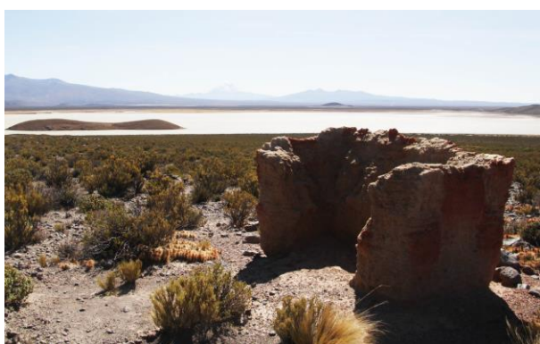
FIG. 6: Espalda fuertemente erosionada de una chullpa decorada con cuadrados rojizos en la cercanía de la laguna e isla de Sacabaya. Como sucede a menudo, el frente y el vano permanecen en buen estado, pero la bóveda y la parte trasera están completamente derrumbadas. Foto del autor.
