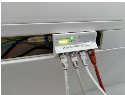
Figure 1: Micro-commutateur en goulotte au C2N
