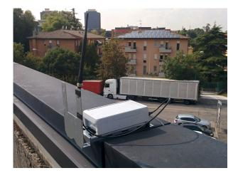
Fig. 3: LoRa<sup>TM</sup> gateway installation.
