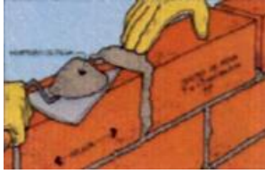
Figura 84. Vulnerabilidad baja: calidad de las juntas de pega en mortero
